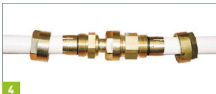
Colocar el racor ajustable entre los dos extremos de la tubería y ajustar con las tuercas de conexión
