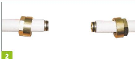
Verificar el diámetro interior del tubo con el calibre y seleccionar el casquillo de refuerzo adecuado.
