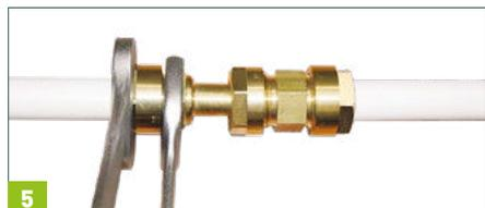
Conectar las tuercas de ambos lados con el racor ajustable mediante llave fija.
